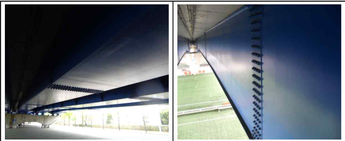
거더 외부 전경
