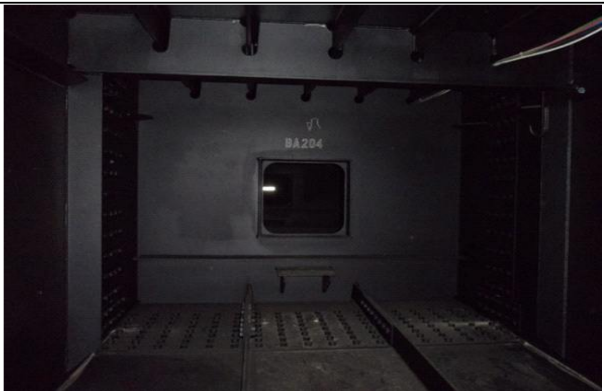
상부구조 전경 - 내부
