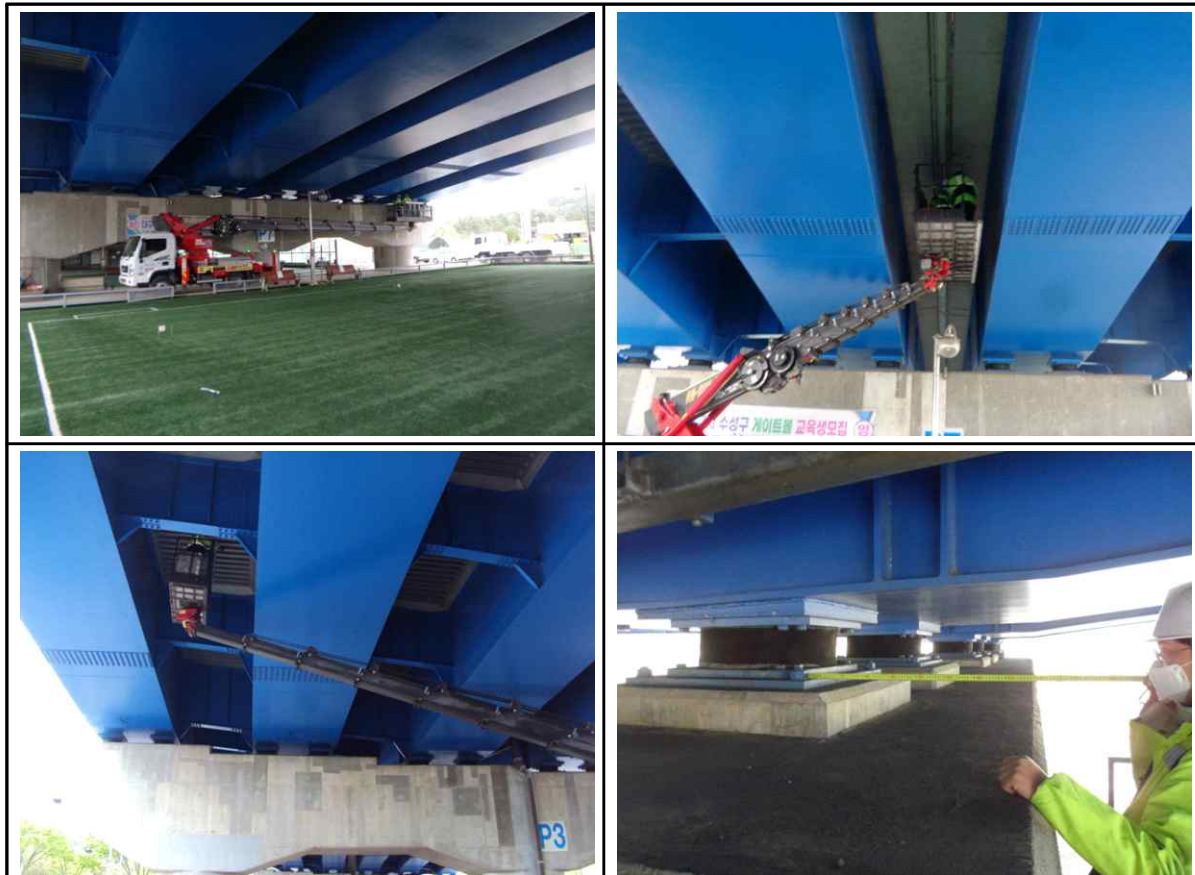
&lt;그림 3.2&gt; 고소작업차 등을 이용한 외관조사
