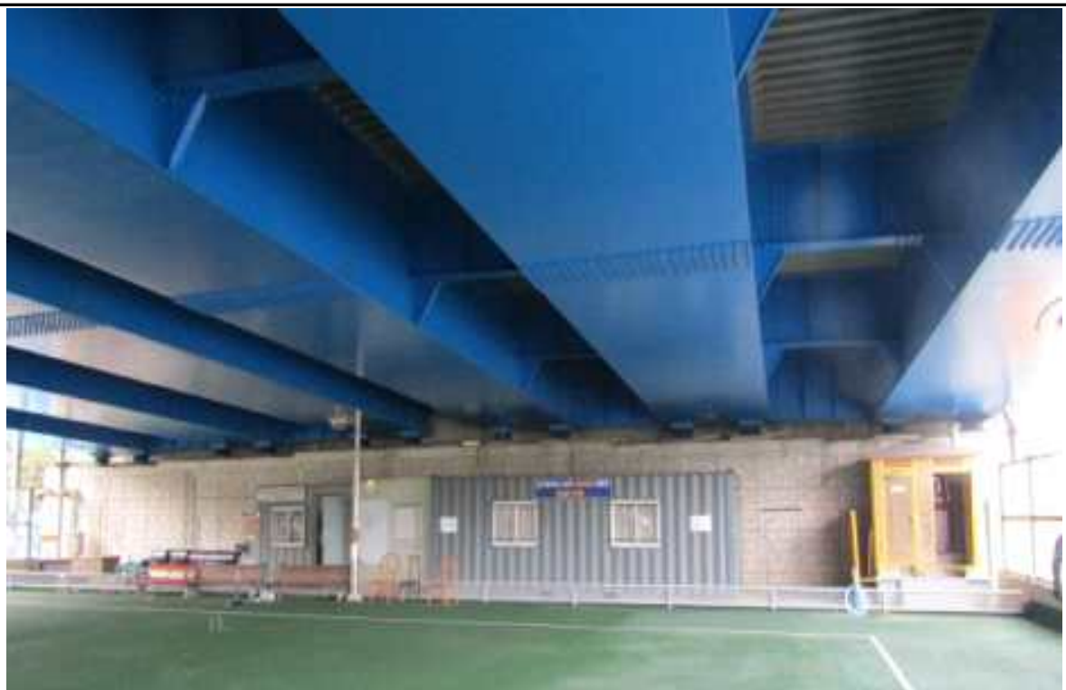
하부구조 전경 - 교대(A2)
