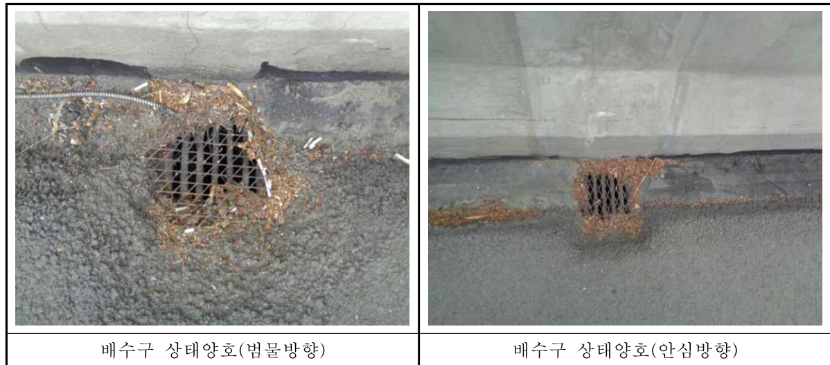
<표 3.24> 배수시설 외관조사 결과
