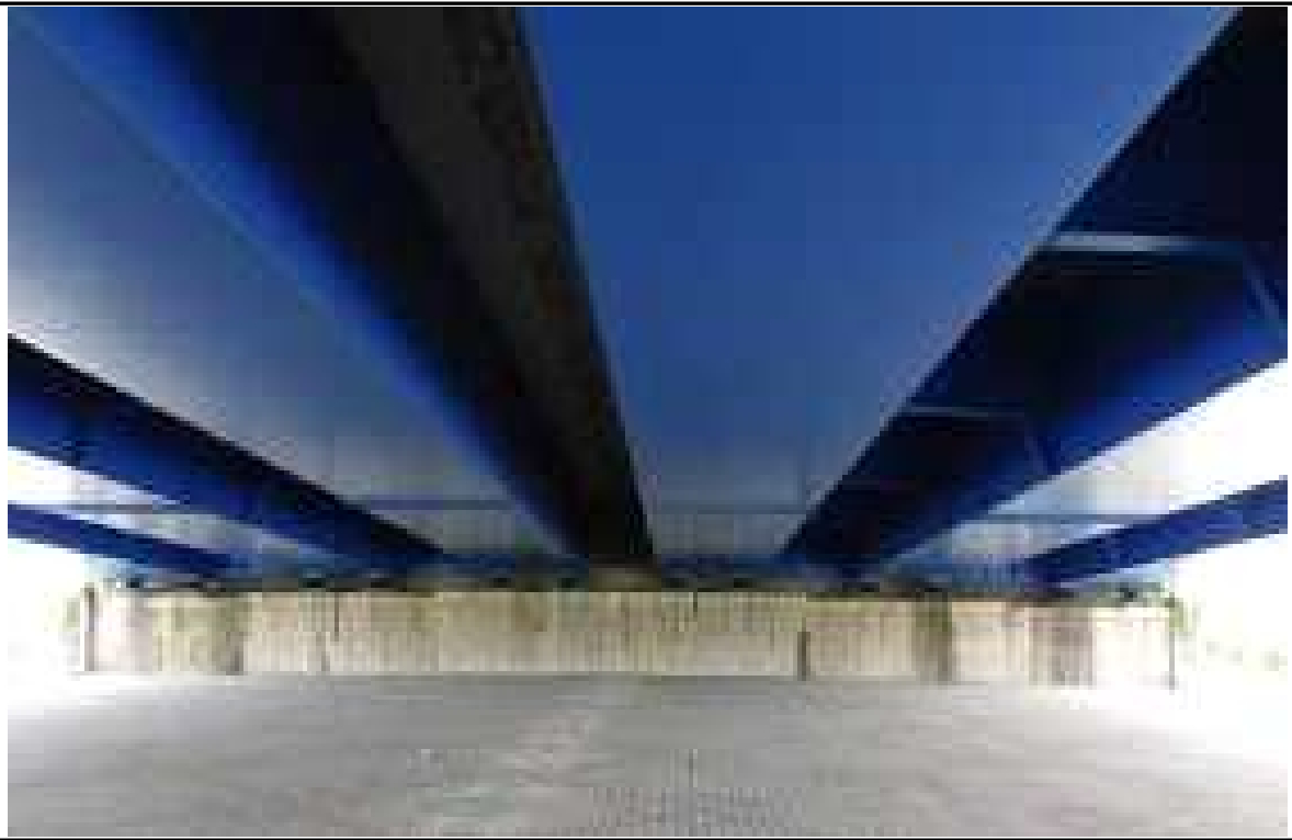
하부구조 전경 - 교대(A1)
