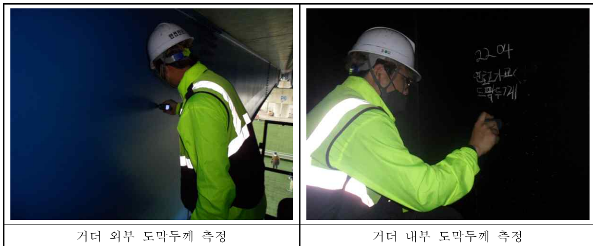
<그림 3.19> 도막두께 측정
