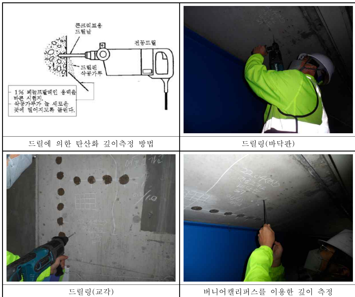
<그림 3.10> 드릴에 의한 탄산화 깊이 측정
